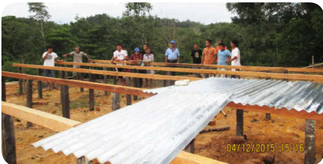
Lokasi Pembangunan Gereja Katolik Stasi Serong
